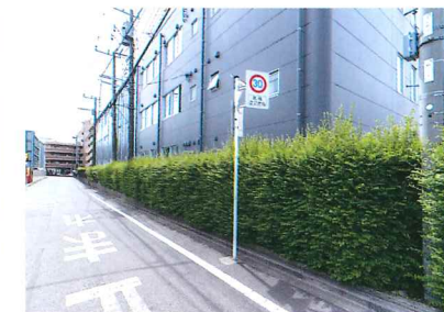
インフラ施設の建物周辺
