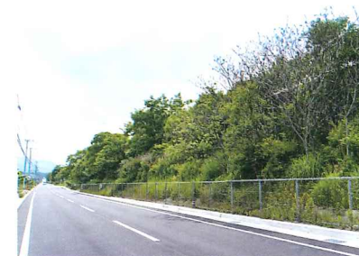
のり面及びインターチェンジ周辺
