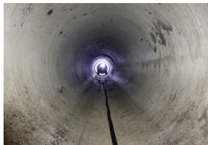
小口径カルバート内の点検状況
